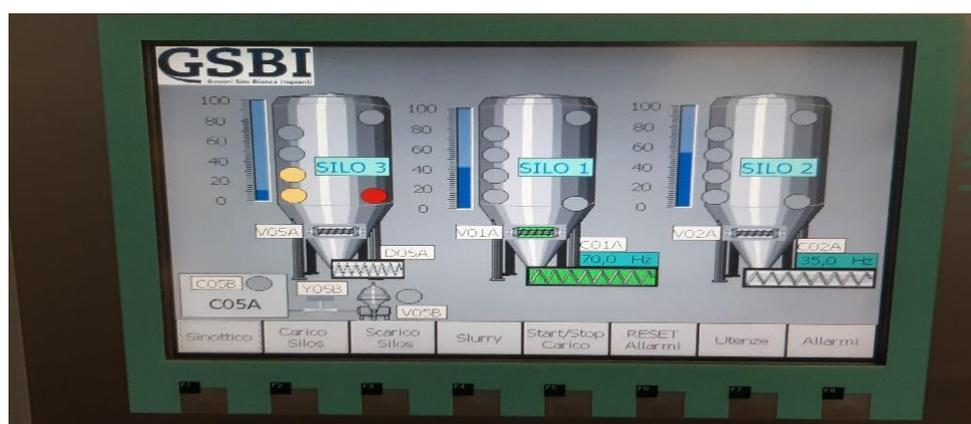
Durante il carico in un silo con livello minimo assicurarsi che non vi sia un prelievo in corso su quel silo.
